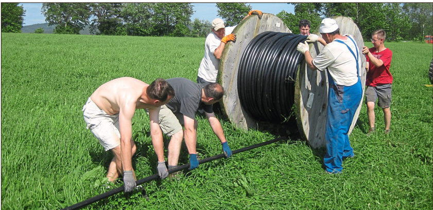
Eine der letzten Arbeiten war das Aufrollen des über 200 Meter langen Stromkabels.
